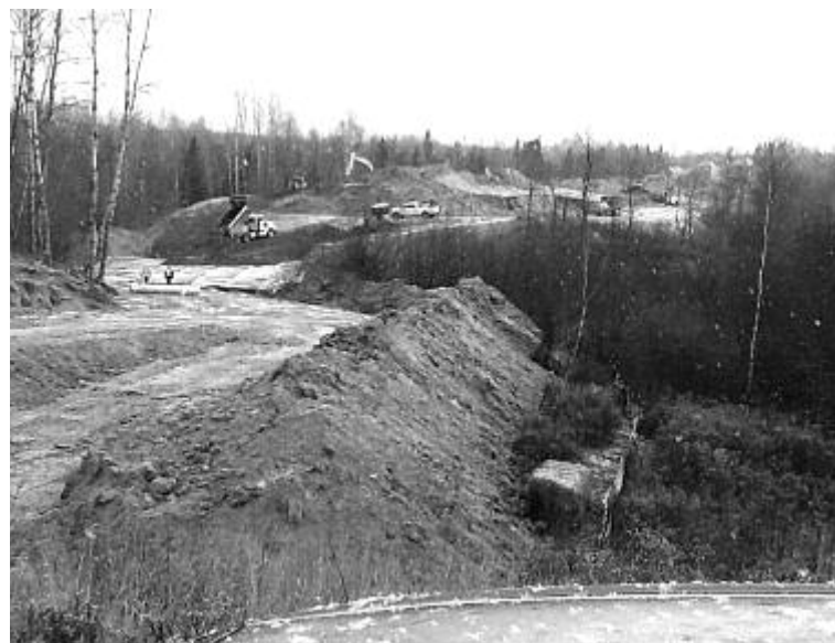
Une vue du projet domiciliaire Clos-Petit-Mont où les travaux de déboisement et de nivelage du terrain interpellent les citoyens.
