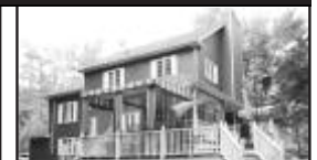
Avec piscine creusée
