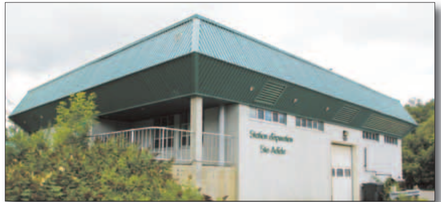
L'usine d'épuration Mont-Rolland, mise en fonction en octobre 1986, a une moyenne de 31 291 coliformes fécaux/100 ml en ce qui a trait aux rejets des sept dernières années. Un système de traitement tertiaire de désinfection au rayon UV permettrait de réduire de 90% ces rejets en tout temps.
